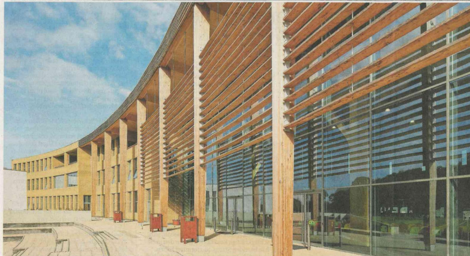
Das Aussen beeinflusst das Klima im Innern: Eine «Brise-Soleil»-Konstruktion aus Holz und Glas von Sheppard Robson Architekten.
